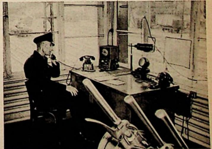
Rangler-Verkehr durch UKW gesteuert. Vom Stellwerk eines Industrie-Bahnhofs im Kohlenpott werden die Rangierloks durch UKW gelenkt (Werkfotos Telefunken)
