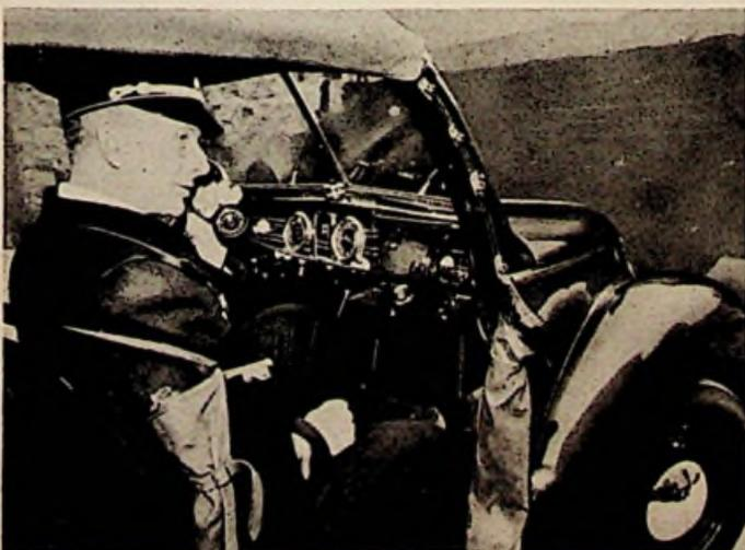
Polizeifunk auf UKW. Der Kommandeur des Funkstreifen dienstes empfängt und sendet vom Wagensitz aus. Das Bedienungsgerät ist im Handschuhkasten
